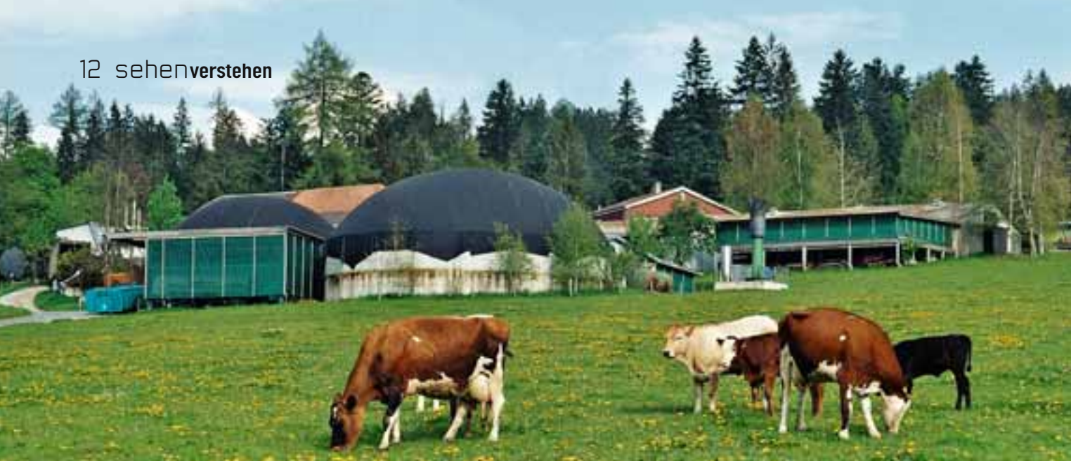
Der Hof der Gebrüder Klaus und Urs Wittwer, Schallenberg i.E.: Seit der Erstellung im Jahr 1994 wird die Biogasanlage ständig optimiert.
